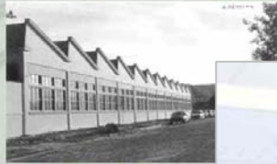
Μέρος των γραφείων και των εργαστηρίων του ανακαινισμένου εργοστάσιου Παπαρήγα (φωτ. Α. Παπαρήγα)
